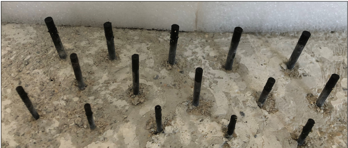
Şekil 6- Beton yüzeye çakılan çiviler. Arka sıra: 6 mm çapında çiviler, orta sıra: 5 mm çapında çiviler, ön sıra: 4 mm çapında çiviler.
